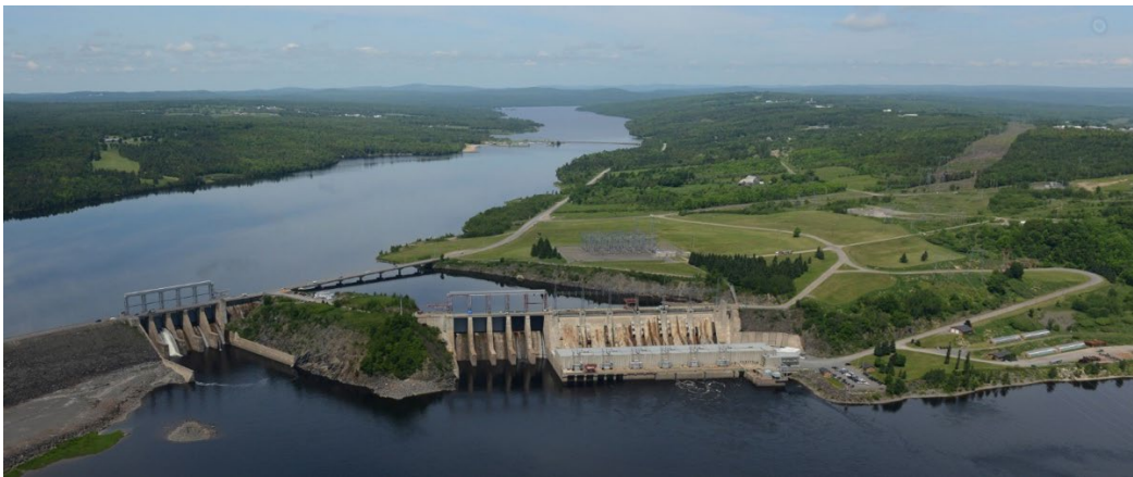
Figure 2.2: Centrale hydroélectrique de Mactaquac
